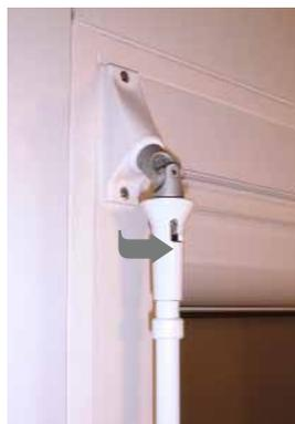
Après l'utilisation de la manoeuvre manuelle de secours, il est conseillé de ramener le volet en position entr'ouverte avant de relancer un mouvement complet à l'aide du point de commande.
